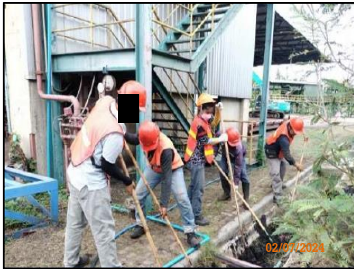
ภาพที่ 2.37 การขุดลอกกระบายน้ำภายในพื้นที่โครงการ
