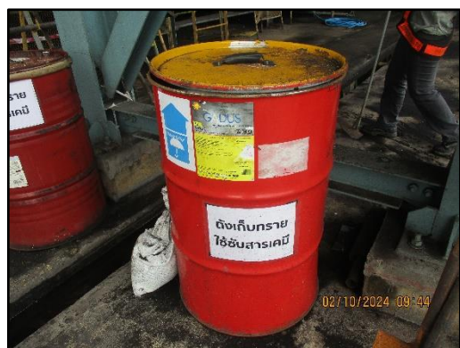
ภาพที่ 2.20 ถังทรายศูดูดซับน้ำมันบริเวณท่าเทียบเรือของโครงการ
